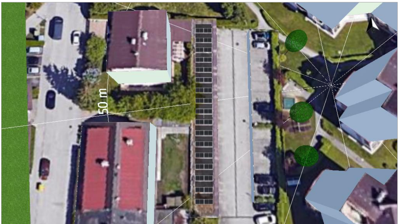
Abbildung: 1. Modulfläche - Gebäude 08-Modulfläche Süd
